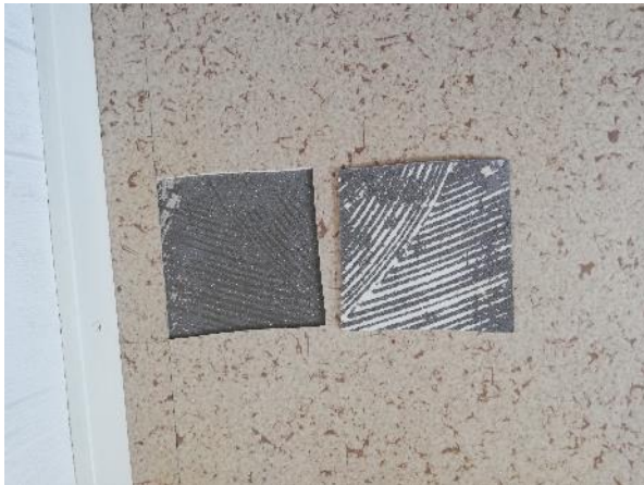
Kuva 16: Asuinhuoneiston alapohjarakenteen muovimatonäyte.
