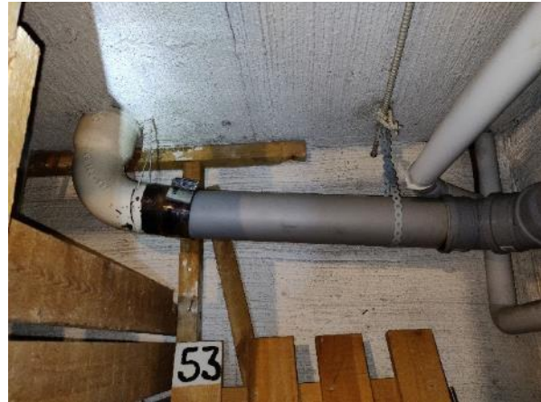
Kuva 60. Kellaritiloissa oleva uusittu liitoskohta.
