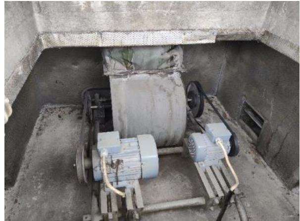
Kuva 62. Poistoilmamuri vesikatolla.
