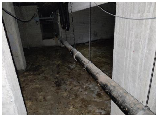
Kuva 58. Alkuperäinen valurautainen jätevesiviemäri tuulettuvassa alapohjassa.
