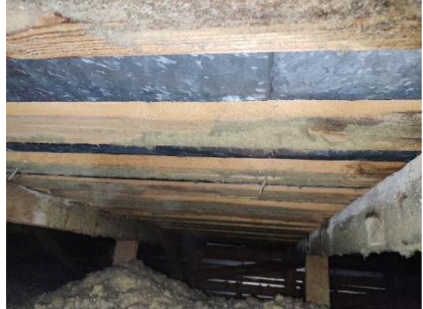
Kuva 39: Peltikatteen alla ei ole aluskatetta.
