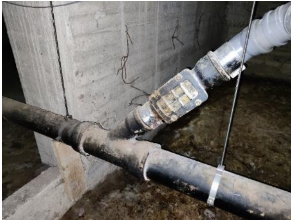
Kuva 59. Alapohjan tuulettuvassa tilassa oleva alkuperäisen ja uusitun viemärin liitos.
