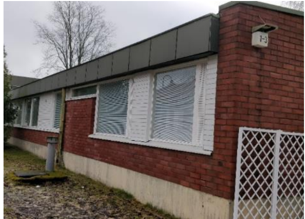
Kuva 27: Huoltorakennuksen pellitysten tilalle on tehty panelointi.
