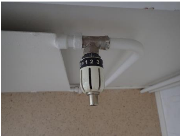
Kuva 51. 1980-luvun patteriventtiili.
