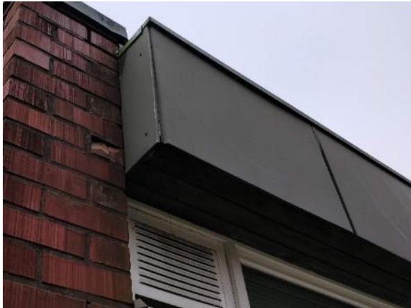
Kuva 44: Yläpohjan tuuletus tapahtuu räystäiden kautta.
