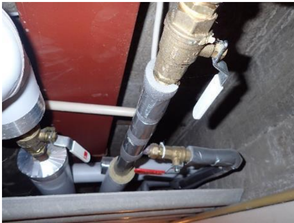
Kuva 53. Kellaritilan alakattotiloissa havaittiin 2000-luvulla uusittuja vesijohtoja.
