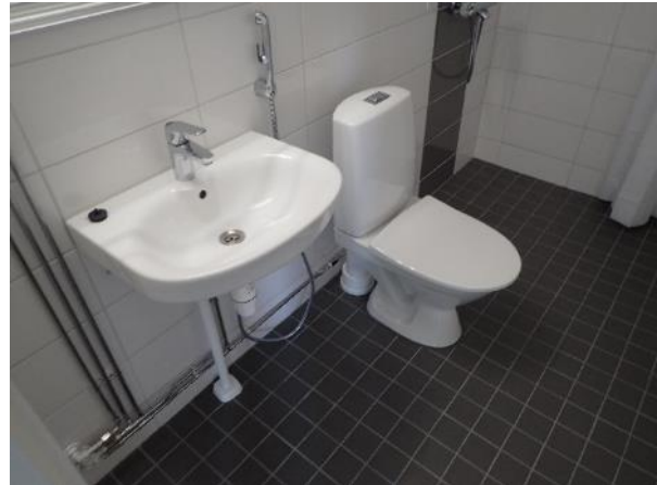
Kuva 56. Asuinhuoneiston pesuhuonetila saneeratussa kunnossa.
