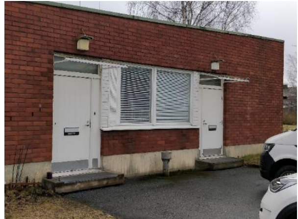
Kuva 7: Huoltorakennuksen uusitut ulko-ovet.
