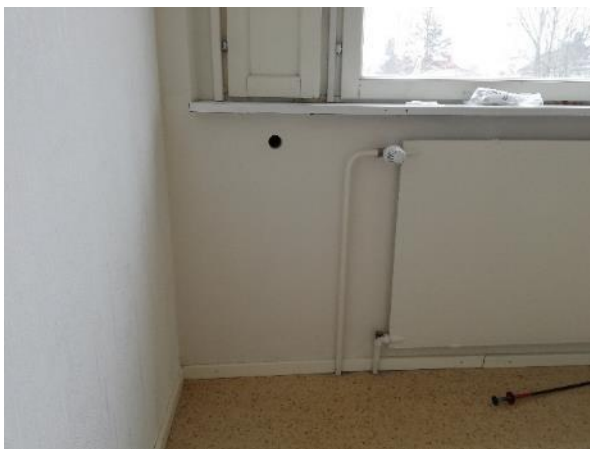
Kuva 32: Ulkoseinän rakenneavaus.
