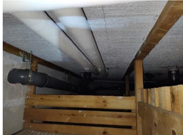
Kuva 50. Asbestipitoisia putkieristeitä.
