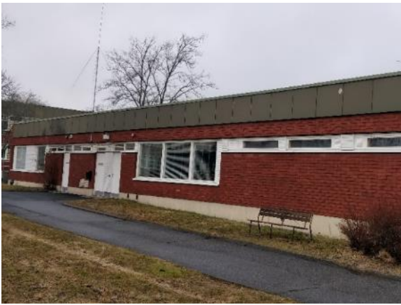
Kuva 28: Julkisivun räystäspellitykset.
