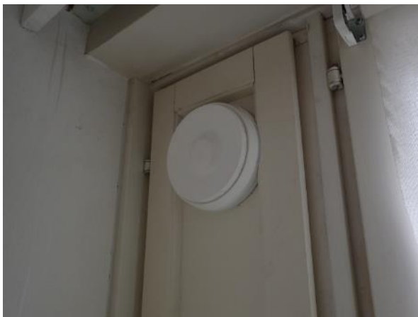
Kuva 65. Raitisilmaventtiili asuinhuoneistossa.
