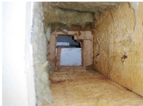
Kuva 33: Levyrakenne ikkunoiden kohdalla.
