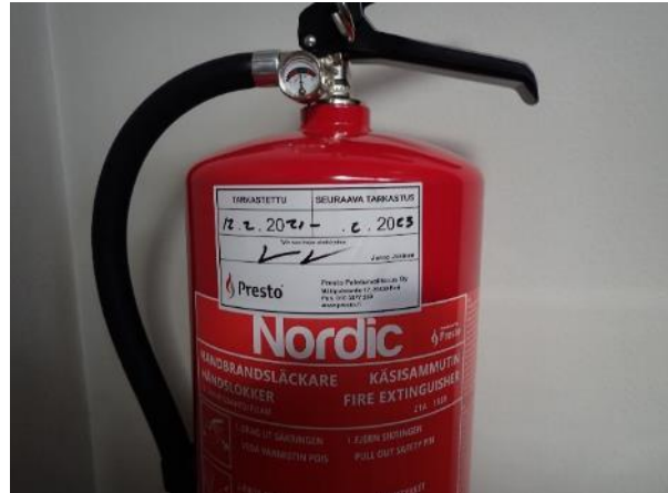
Kuva 68. Jauhesammutin huoltomerkintäkilpien.
