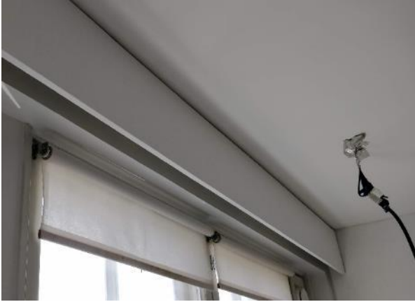
Kuva 46: Yläpohja-seinäliittymät ovat tiiviit.
