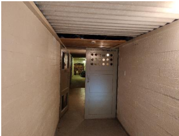
Kuva 36: Väliseinät ovat pääosin tiili- ja betonirakenteisia.
