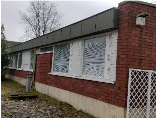
Kuva 10: Huoltorakennuksen ikkunat ovat sisäänpäin aukeavia kaksi puitteisia ja kolmilasisia puu – alumiini – ikkunoita.
