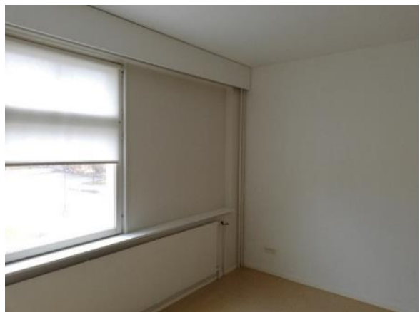
Kuva 31: Ulkoseinien sisäpinnoissa ei ollut havaittavissa vaurioita.
