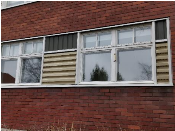
Kuva 8: Asuinrakennusten ikkunat ovat sisäänpäin aukeavia kaksi puitteisia ja kolmilasisia puuikkunoita.
