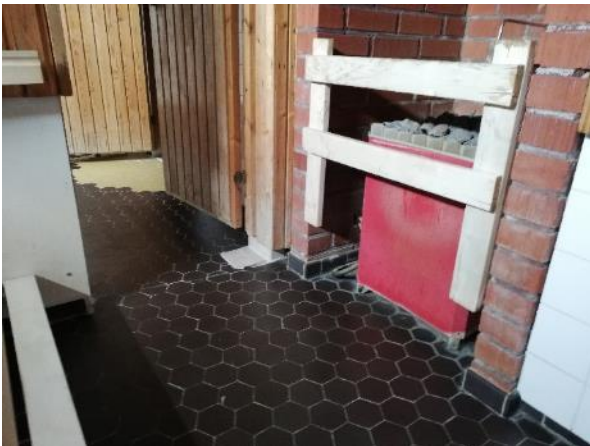
Kuva 14: Yleisten saunatilojen laattalattia.
