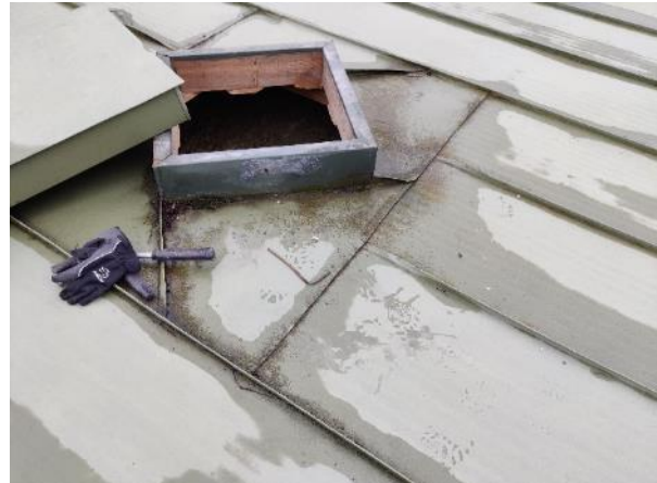
Kuva 45: Yläpohjan tarkastusluukku.
