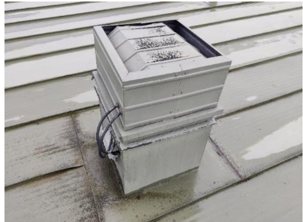
Kuva 64. Poistoilman huippumuri vesikatolla.
